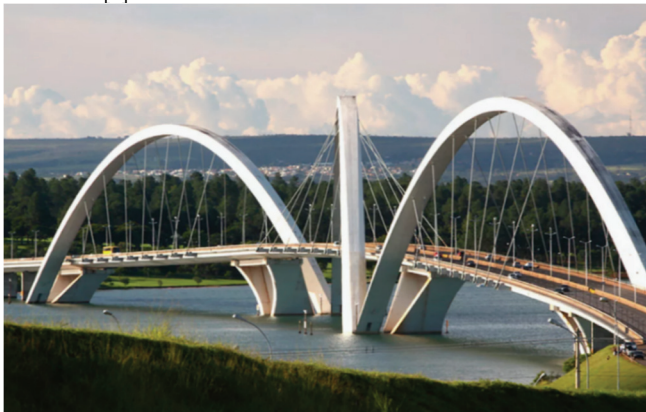
Рис.10. Пилоны вантового моста Жуселину Кубичека (Бразилия). Источник: https://eor.stu.ru/pluginfile.php/211939/course/overviewfiles/2022-10-26-21-37-17.jpg
